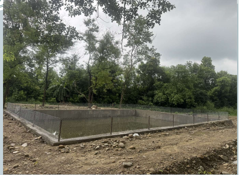
राधाकृष्ण पुनर्भरण पोखरी निर्माण सैनामैना १० रुपन्देही
